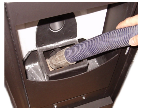
Fig. 3 – Nettoyage du compartiment de dépôt des cendres
